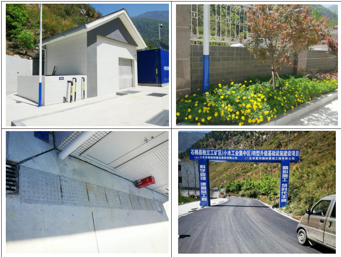
图 5-1 工程区现场运行情况
